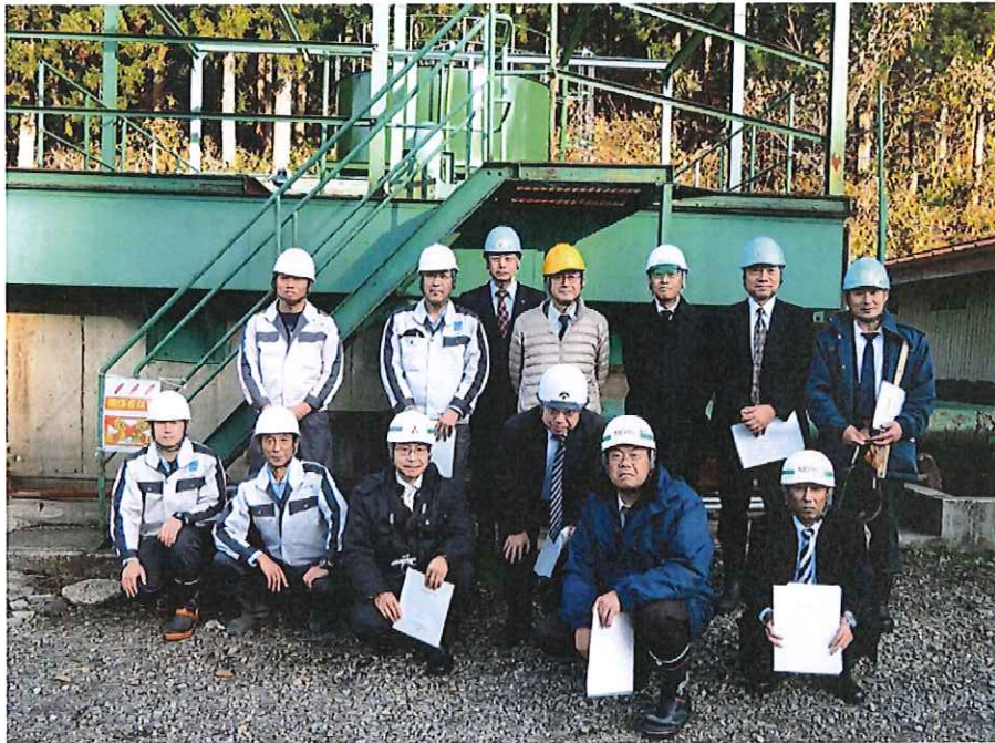
廃水処理設備
